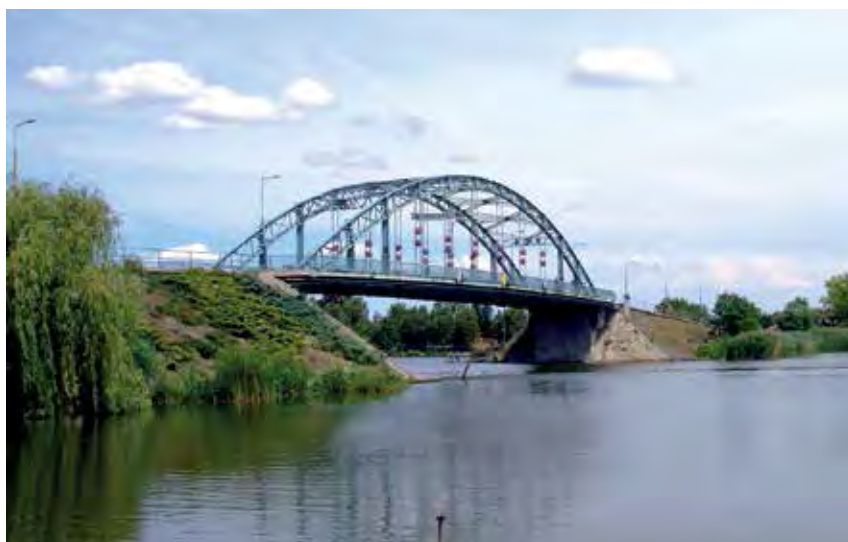
8. kép: A híres Árpád híd
