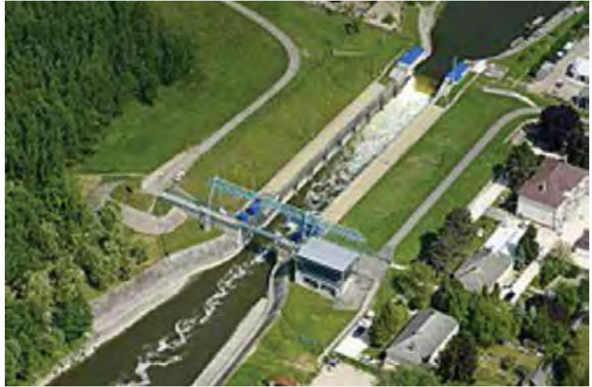
12. kép: A Tassi-zsilip felülnézetből
